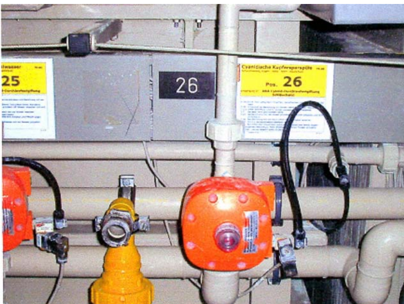
Abbildung 4.7: Beschriftung von Wannen mit gefährlichen Arbeitsstoffen (Firma F)
