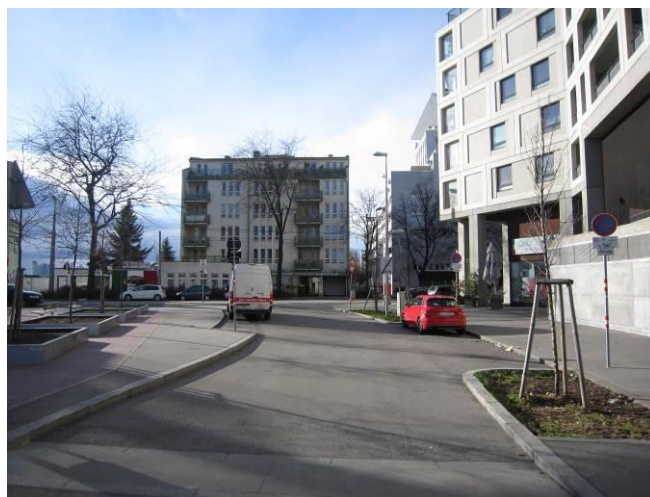
Umsetzung §53-Straße Blick Richtung Donaufelder Straße, entlang des Schulcampus auf der linken Seite
