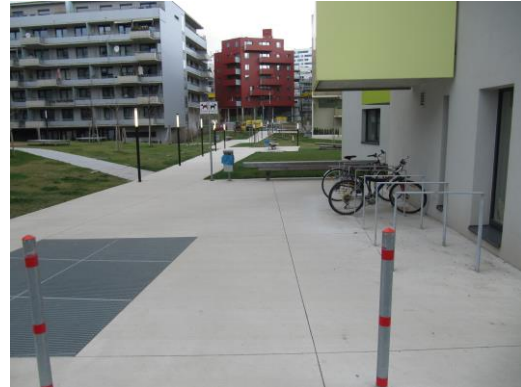
Sonnendviertel: Bauplatzübergreifender Durchgang
